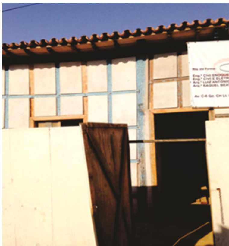
Figura 4: Casa de Enxaimel em restauração Fonte: Arquivo da Vestígio Arqueologia e Meio Ambiente.
